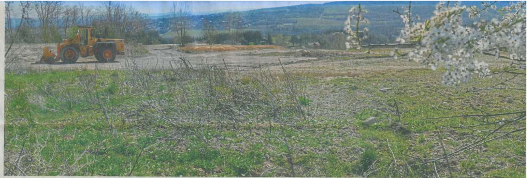
Auf der ehemaligen Kiesgrube Rummelsheim ist es inzwischen Frühling geworden.
